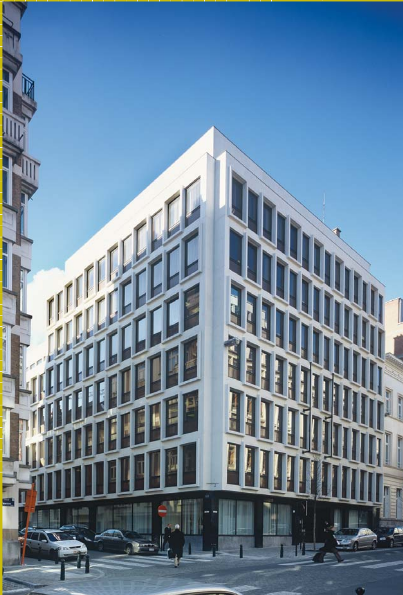
rue Montoyer 63, 1000 Bruxelles
