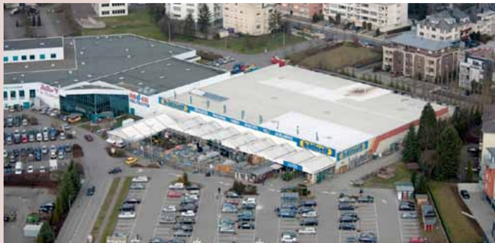
Route d'Arlon 2, Strassen
