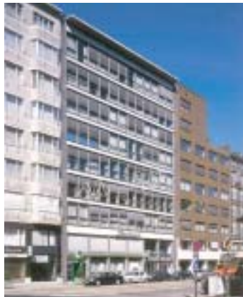
Mechelsesteenweg 30-34 + Parking J.F. Willemstraat 1
