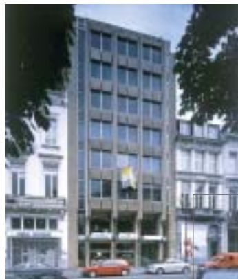
Kantorencomplex recht tegenover het Conrad hotel bestaande uit 2 met elkaar verbonden gebouwen en 1 commercieel gelijkvloers
