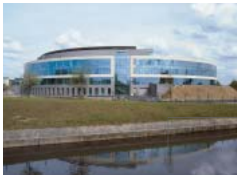
Nouvel immeuble de bureaux dans le Parc Scientifique Erasme à Anderlecht
