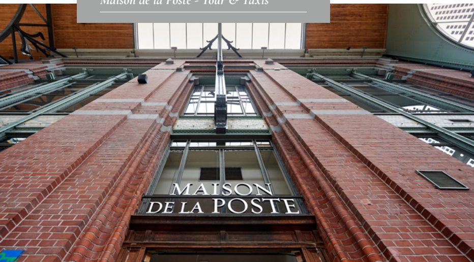
Maison de la Poste - Tour & Taxis
